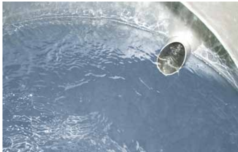
Gesteigertes Augenmerk wurde auf die optimale Mediumsführung in der Anlage gelegt.
